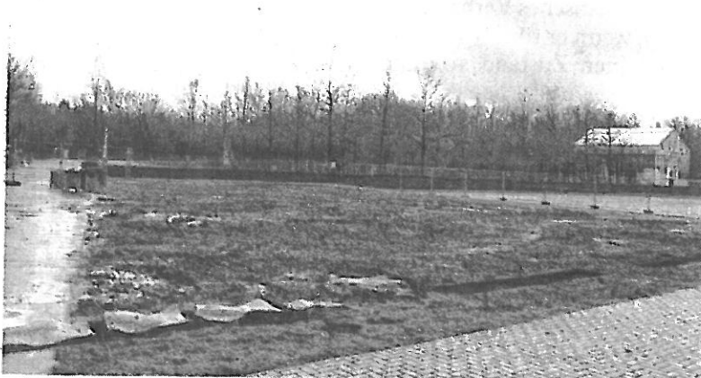
Große Fläche: Hier stand der Schornstein. Ende März soll der Mutterboden eingesät werden.
